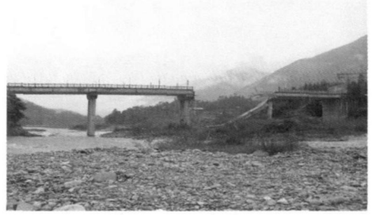
图 3 高原大桥落梁
