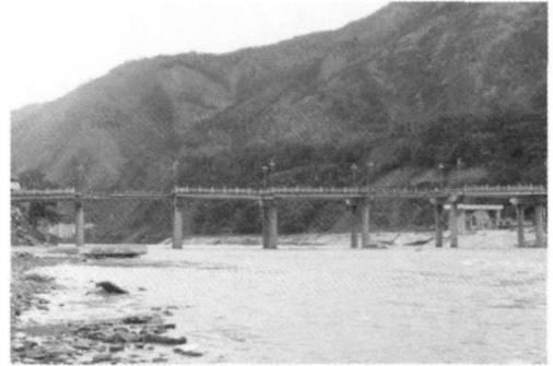
图 4 龙尾大桥落梁
