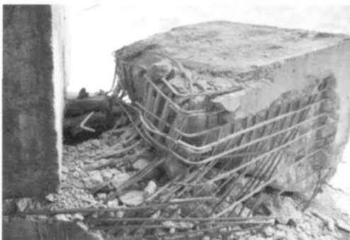
(b) 挡块纵筋粘结破坏
