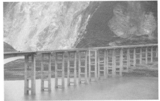
图 12 庙子坪大桥引桥落梁(高墩桥)
