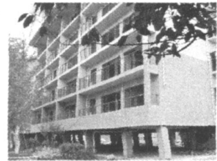
(a) 都江堰市某框架结构底部
