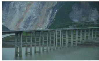
(a) 庙子坪大桥引桥落梁
