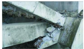
(i) 拱圈(肋)的剪切破坏 (北侧第1跨)
