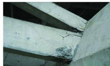
(n) 拱肋地震破坏模式及薄弱环节
