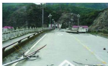
(e) 桥面弯曲, 高低错落
