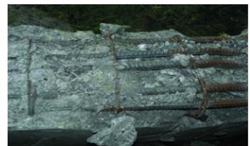
(l) 拱肋节点处的箍筋构造
