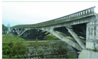
(e) 北侧2跨的整体破坏形态
