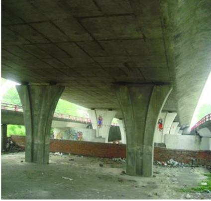
图 12 主桥下部结构基本完好
